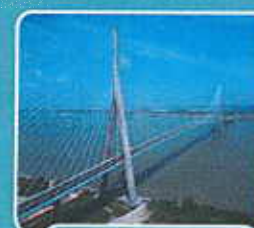
Pont de Normandie
