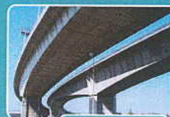
Viaduc de Gennevilliers
