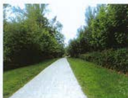
Sentier en sable stabilisé
