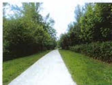
Sentier en sable stabilisé
