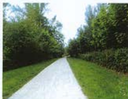
Sentier en sable stabilisé
